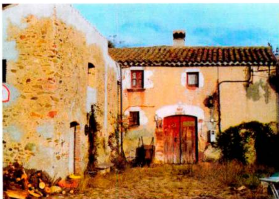
Façana Principal. Foto F. Sarrià, 2001.
