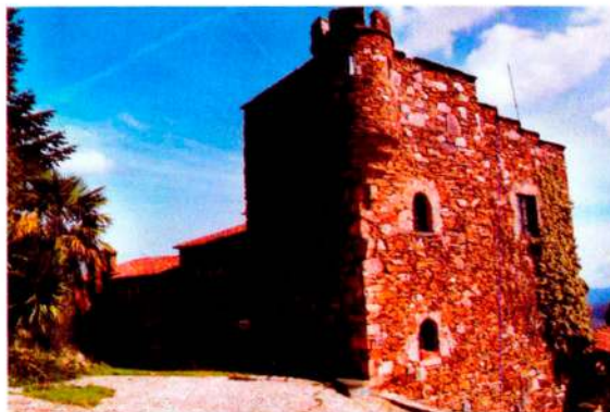
Façanes nord i ponent. Foto: F. Sarrià, 2002.
