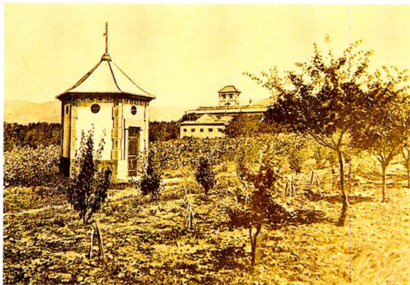
Pou d'extracció d'Agua de mesa «M»
