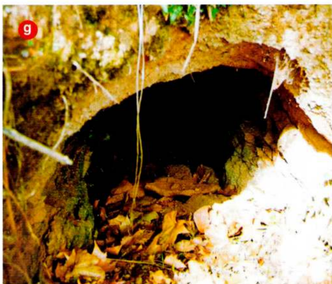
g.- Mina d'aigua sense revestir.
