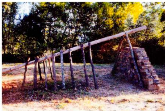
Barraca en construcció, a Cànoves, on cada dos o tres anys es fa una pila carbonera; aquesta correspon al 1999.
