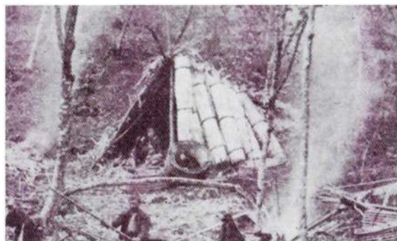
Barraca de rodors. Els laterals estan fets amb paquets de tires de castanyer, sense recobrir, i no té el muret de pedra seca. Sant Hilari Sacalm. Autor i data desconeguts.
