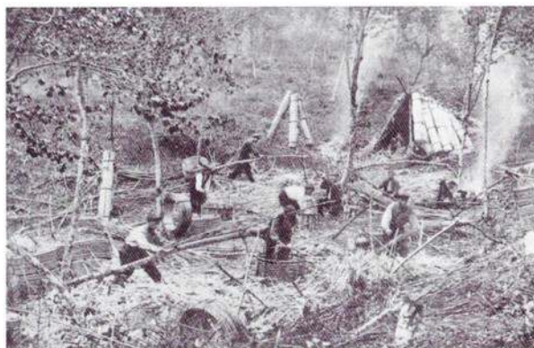
Roders treballant en un esteller. S'observen piles de rotllats, paquets de tires rectes, motlles i bancs de xapar i d'allisar. Sant Hilari Sacalm, data i autor desconeguts.
