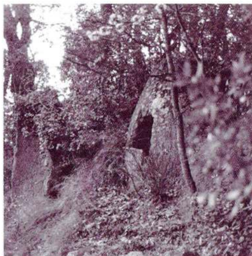
Restes dels forns de pega de Can Valls, uns dels més ben conservats. Olzinelles, 1984.
