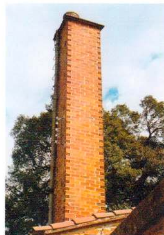
Torre d'un dipòsit d'aigua construït cap a 1945.
