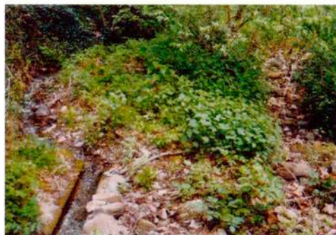
Captació mitjançant una derivació (a l'esquerra) efectuada directament en el llit de la riera (a la dreta).
