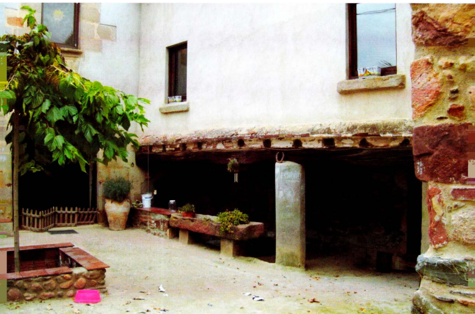
Entrada principal. Antic paller (avui casa) adossat al cos principal.
