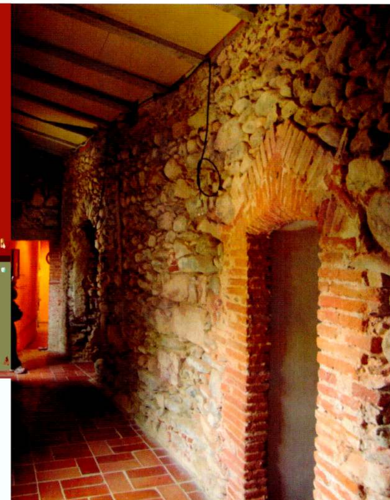
Casa Llobera Paret original, a l'interior de la casa.
