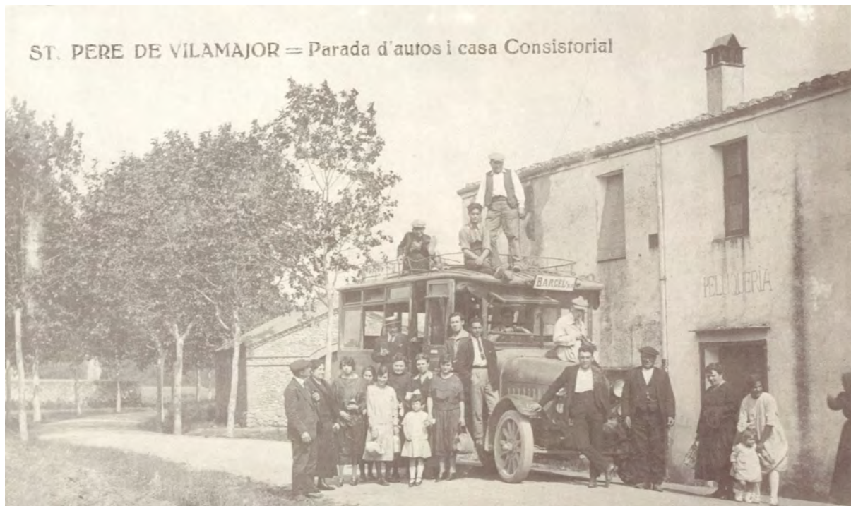
Imatge antiga de Sant Pere de Vilamajor. A la dreta del tot, la casa on va treballar el Josep Amargant (s'aprecia el rètol "Peluqueria"); la porta de la peça on feia els esclòps queda fora de la foto. Aquests edificis es van enderrocar el 1975.
